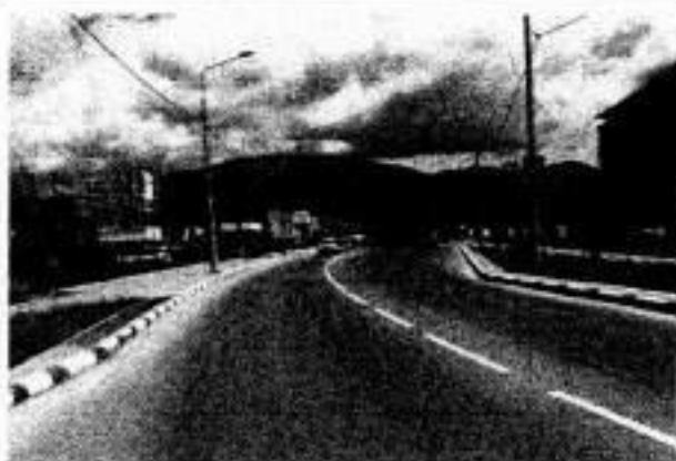
Реконструкция дорожного покрытия
