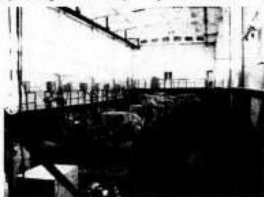
Выполнены работы по техническому перевооружению ПС-7
