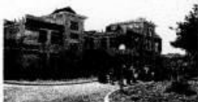
Строительство детского сада по ул. Почтовой в г. Геленджике на 120 мест
