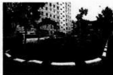
Ремонт дворов и внутриквартальных проездов
